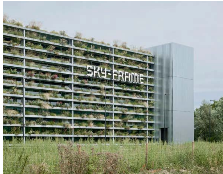
Brise Soleil – Südfassade mit Begrünung
